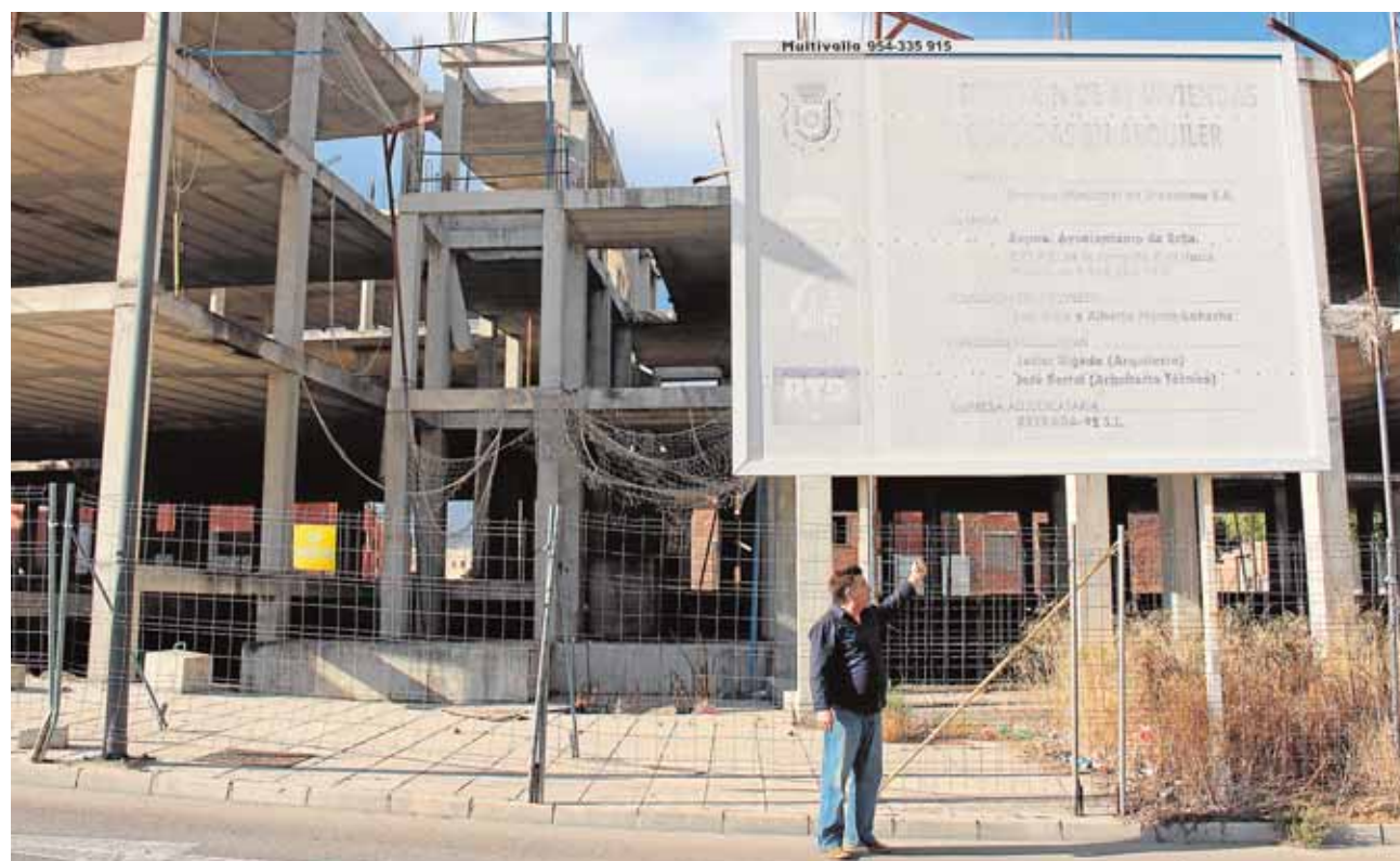
Manuel Camacho señala una promoción de viviendas sociales paralizada en la barriada de El Valle
